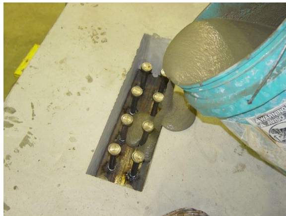
Grout pouring (begin)
